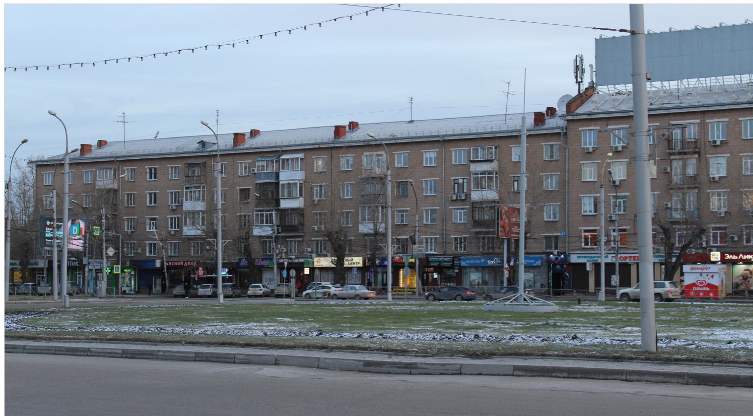
Главный фасад 1-13, выходящий на улицу Ватутина
